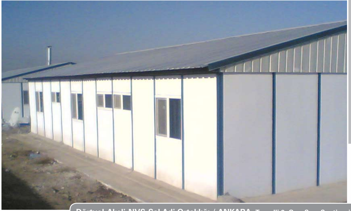
Dörtöyol-Akeli-NVS-Şal Adi Ortaklığı / ANKARA Temelli 3. Org. San. Şantiyesi
